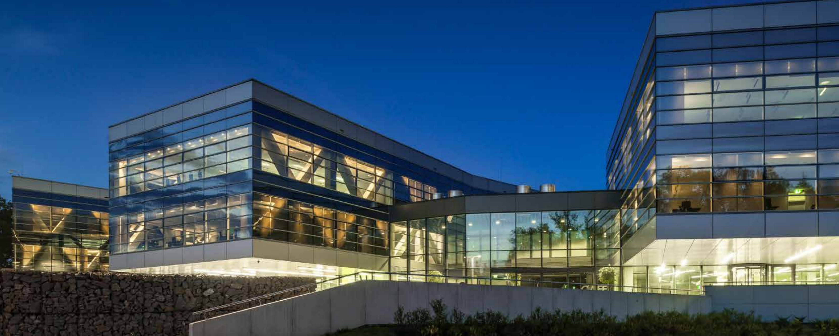
Fot 12. Nowy Sącz, MMC Brainville Park Technologiczny, proj. Artur Jasiński i Wspólnicy Biuro Architektoniczne (2014), fot. archiwum pracowni Artur Jasiński i Wspólnicy Biuro Architektoniczne
